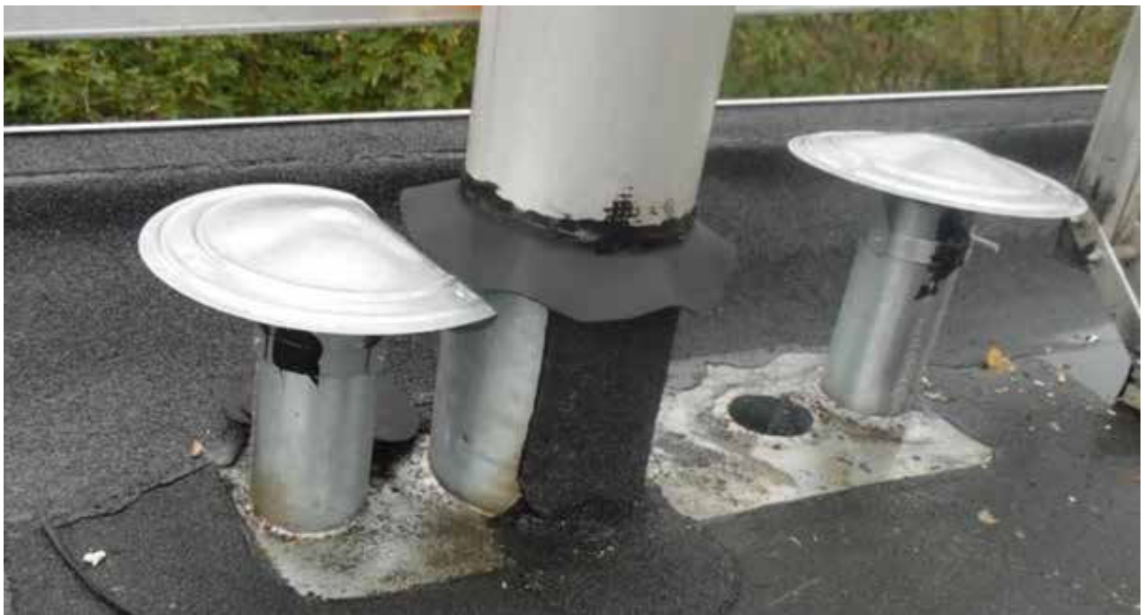
Foto 6: Idem, halverwege renovatie van dit dak
