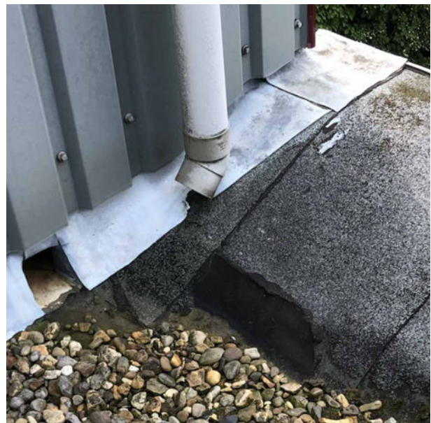
Foto 4: prefab opbouw (container) met dakrand en dakopstand. De hemelwaterafvoer watert af onder de opbouw. (zie ook foto 9A)
