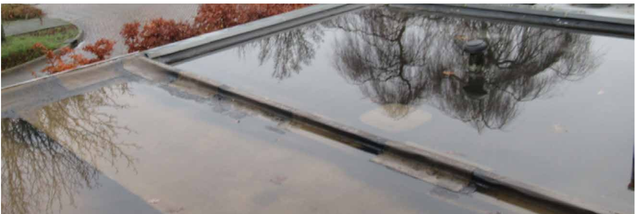
Foto 7a: Nog een voorbeeld van een erfscheidingsbalk bij een garagedak. (met eigen afvoer)
