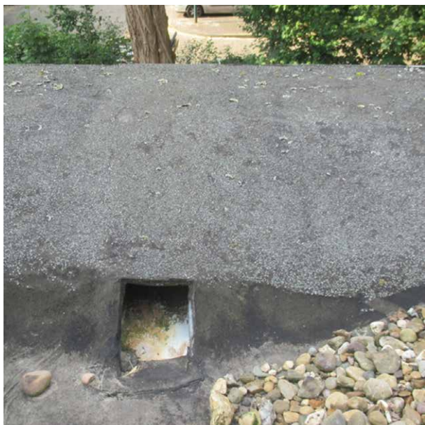
Foto 8: gerealiseerde hemelwaterafvoer in betonrand (zie ook volgende foto 9)
