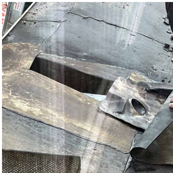
Foto 8a: in realisatie zijnde dakdoorvoer in de betonrand
